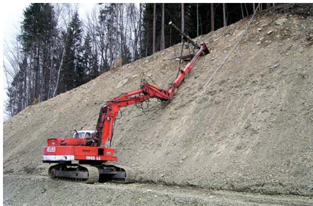
Zbocze w trakcie gwoździowania
