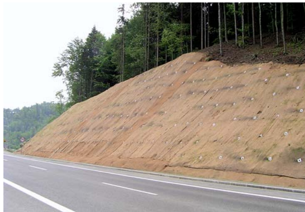
Zbocze po zakończeniu prac
