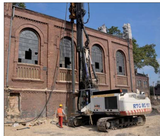
Fot. 4 | Wykonywanie pali DFF wzdłuż ściany budynku MS-8
