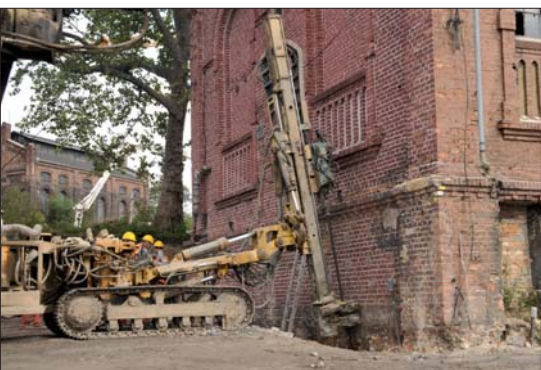
Fot. 3 | Wykonywanie mikropali podchwytyjących ścianę budynku
