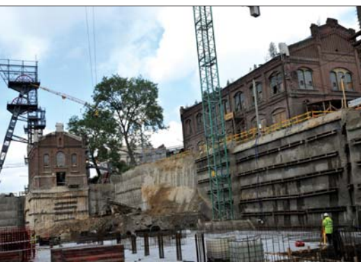
Fot. 2 | Widok północnej ściany wykopu z różnymi rodzajami zabezpieczeń
