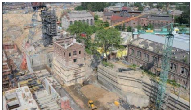
Fot. 1 | Panorama budowy
