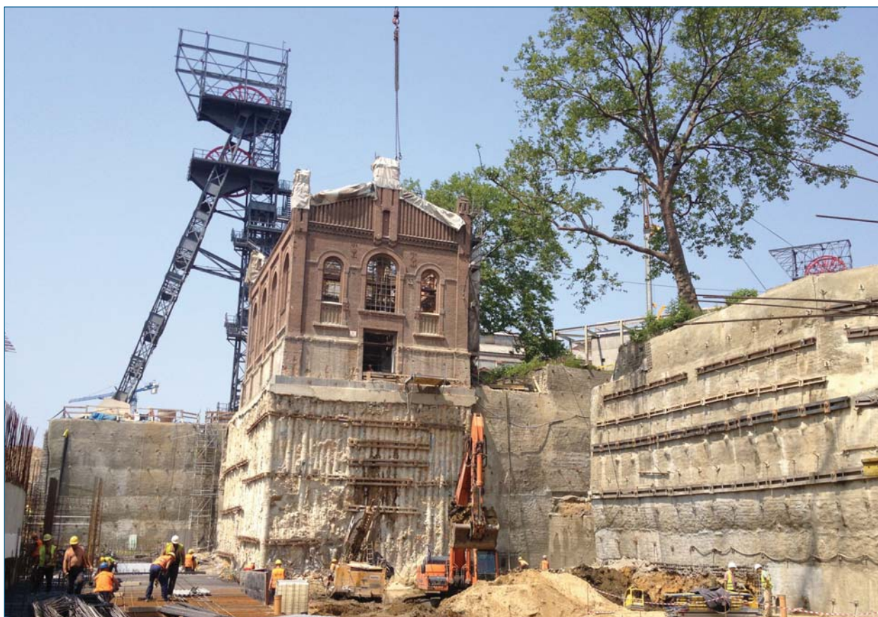
Fot. 7 | Widok w kierunku obiektu MS-8 i Szybu Warszawa
