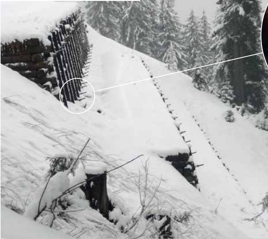
Gwoździowanie muru oporowego, Damüls, Austria
