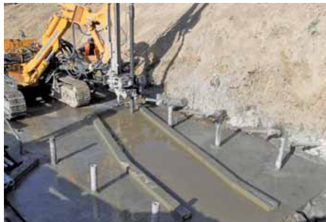
Ryc. 2. Wykonywanie mikropali w fundamencie przyczółka
