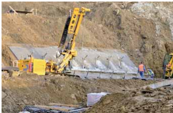
Ryc. 3. Fundament dźwigaru łukowego w trakcie wykonywania mikropali, fot. A. Kulawik
