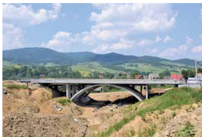
Ryc. 6. Most łukowy w ciągu DE S7 Kraków – Rabka w Lubniu, z fundamentami mikropalowymi, fot. archiwum TITAN POLSKA
