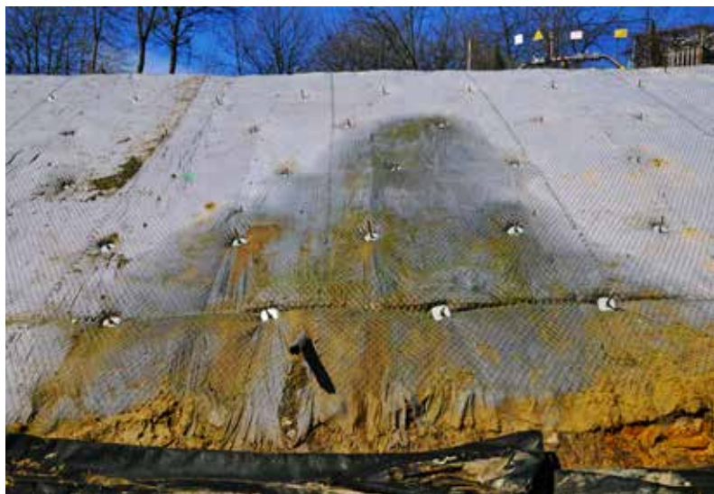
Ryc. 4. Skarpa z widocznymi intensywnymi sączeniami
