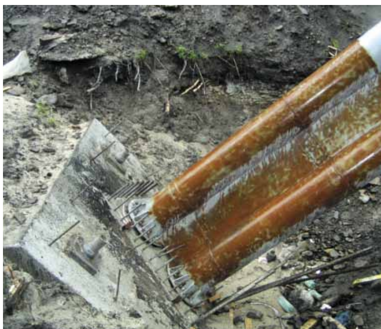
Fot. 8. Fundament słupa nośnego z mikropalami kotwiącymi, Ustroń
