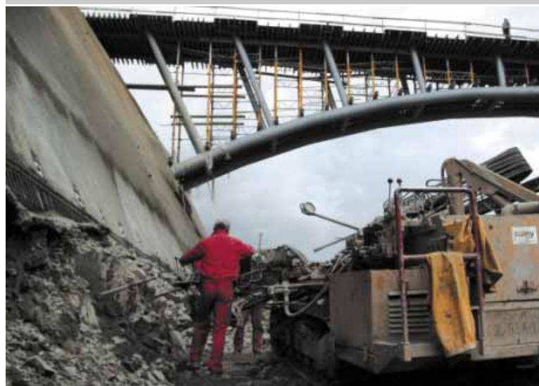
Fot. 3. Wykonana kładka, zabezpieczenie kolejnych poziomów wykopu metodą gwoździowania, Zwardoń
