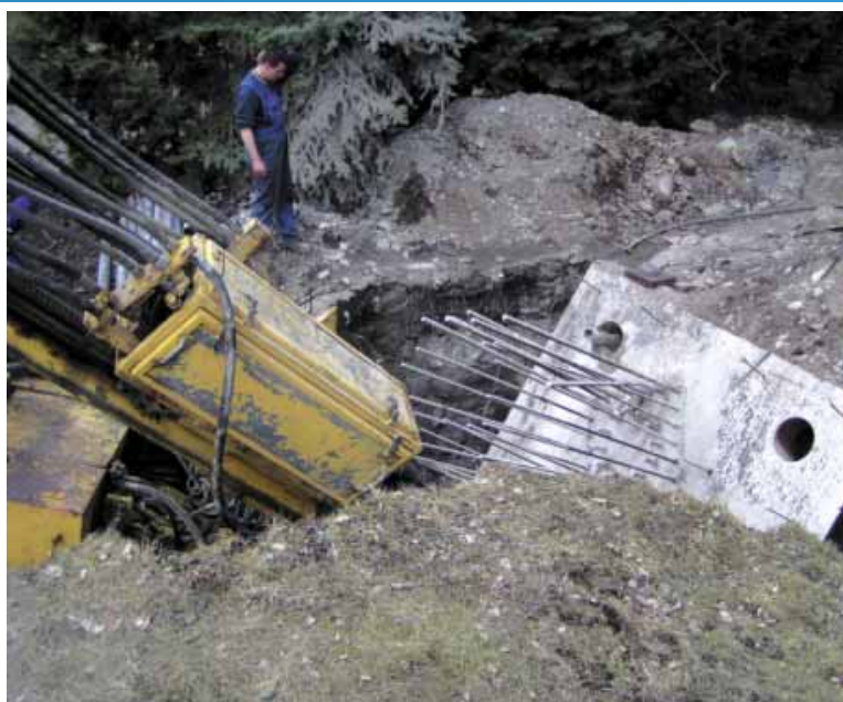
Fot. 7. Wykonywanie mikropali kotwiących pod fundament słupa nośnego, Ustroń
