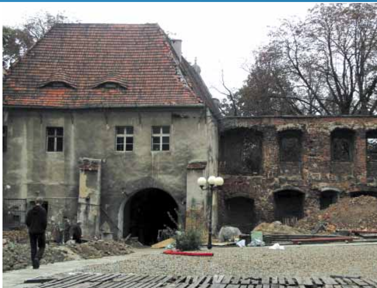
Fot. 4. Budynek Bramy Zamku Piastowskiego, od strony dziedzińca, Racibórz
