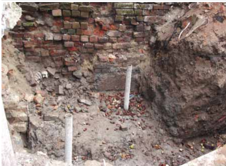
Fot. 5. Mikropale przed wykonaniem belki wsporczej, Racibórz
