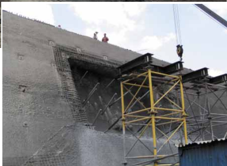
Fot. 2. Widok niszy pod płytę przyczółka – widoczne mikropale i gwoździe gruntowe, Zwardoń
