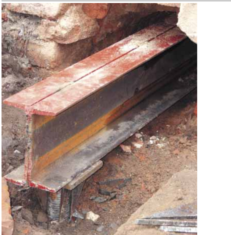
Fot. 6. Konstrukcja podchwytywająca, Racibórz
