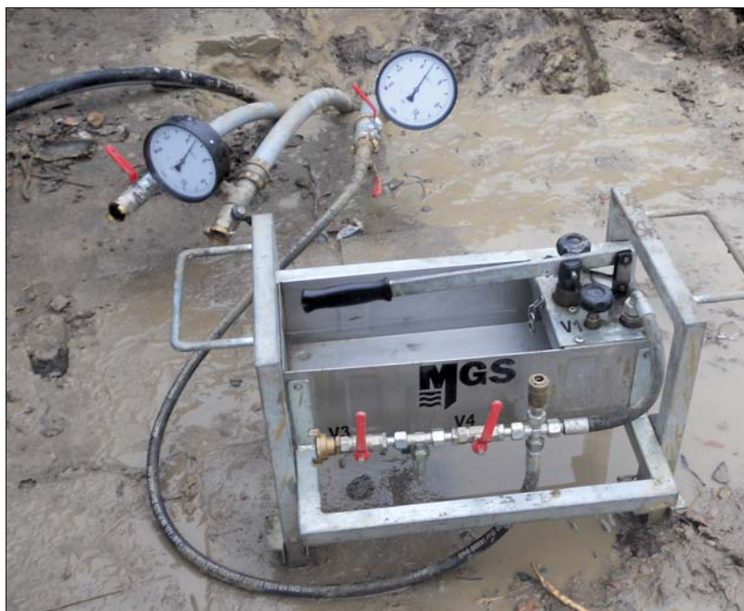
Fot. 3 | Próba szczelności instalacji sondy pionowej za pomocą pompki ROTTENBERGA (fot. archiwum Mostmarpal)
