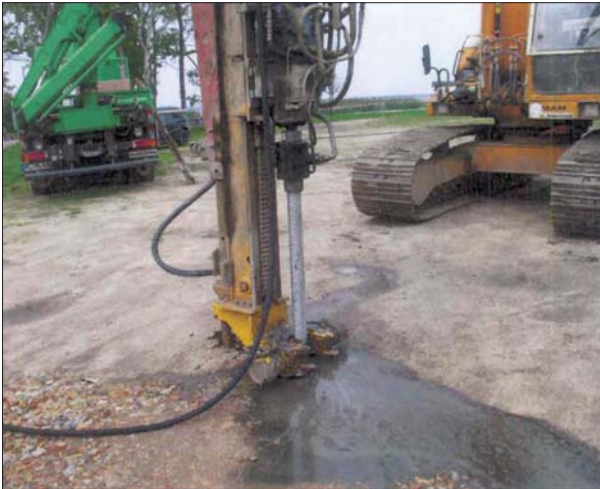
Fot. 4 | Wiercenie mikropala energetycznego
