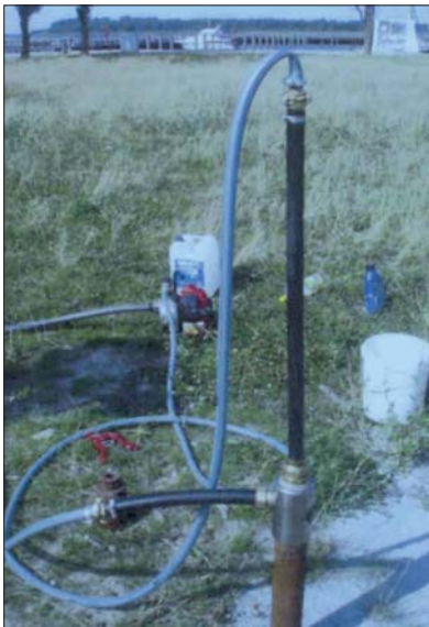
Fot. 6 | Próba ciśnienia i szczelności
