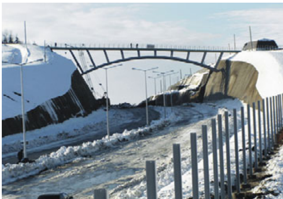
Fot. 3. Widok dwóch skarp po zakończeniu robót, droga ekspresowa S-69, odc. D2
