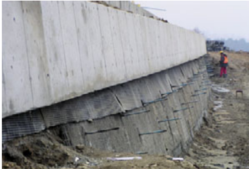
Fot. 4. Ściana gwoździowana w trakcie realizacji, droga ekspresowa S-69, odc. C1
