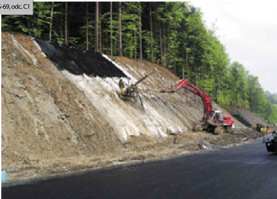
Fot. 5. Skarpa w trakcie gwoździowania – obwodnica Ustronia
