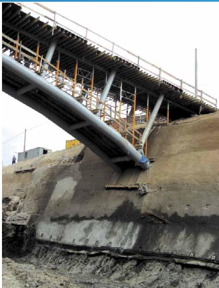
Fot. 1. Kładka łukowa posadowiona na mikropalach – droga ekspresowa S-69 Żywiec-Zwardon
