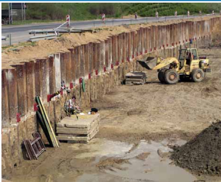
Fot. 2. Trwałe kotwy gruntowe TITAN MONO-JET, Gniezno
