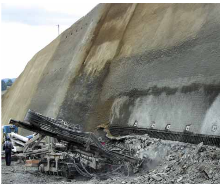
Fot. 3. Gwoździowana ściana torkretowa, droga ekspresowa S-69 Żywiec-Zwardoń
