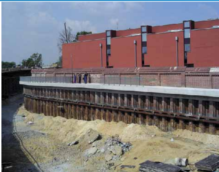
Fot. 5. Trwałe kotwy gruntowe – Trasa Galicyjska
