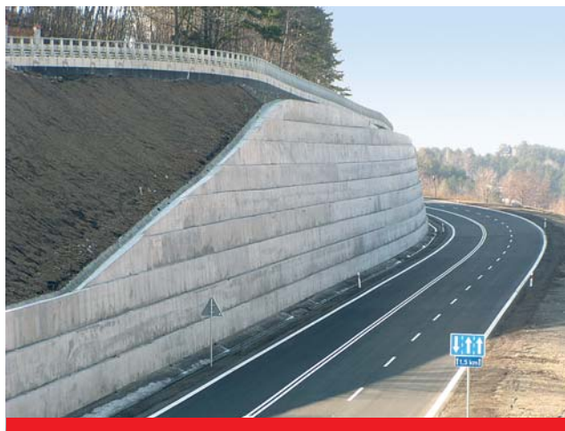
Widok ściany gwoździowanej
