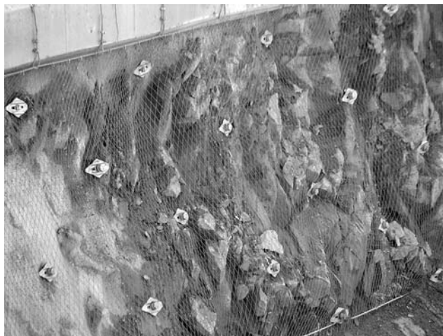
Widok fragmentu skarpy skalnej zabezpieczonej siatką
