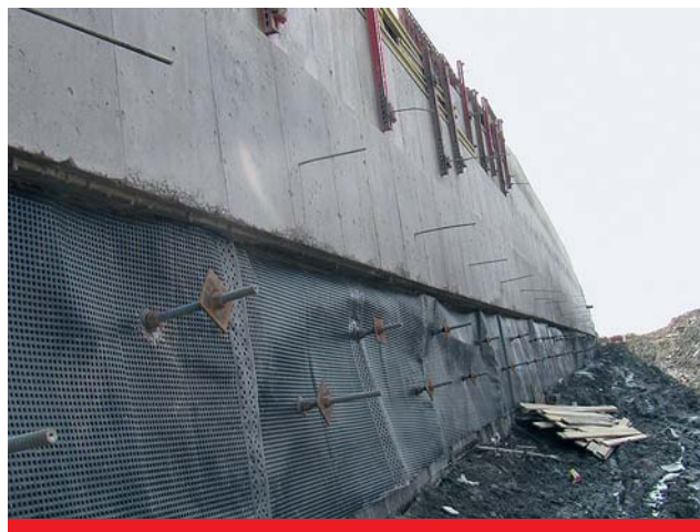
Widok zabezpieczenia doraźnego membrany drenującej i gotowych paneli
