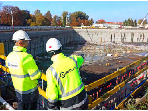
Le chantier en phase de travaux.
