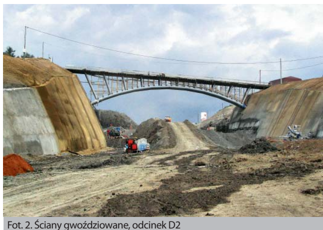
Fot. 2. Ściany gwoździowane, odcinek D2
