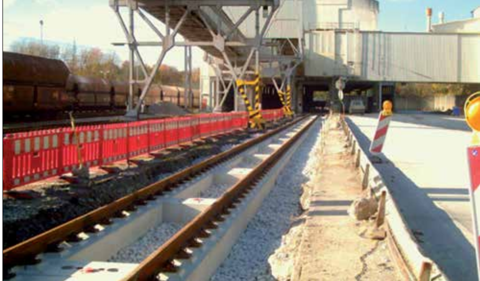
Fot. Nawierzchnia kolejowa bezpodsypkowa NFF po wykonaniu, Kalkwerk Wulfrath
