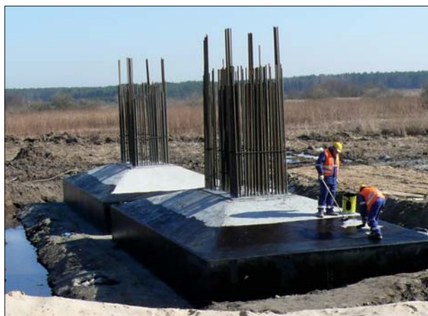
Fot. 3 | Ławy po zabetonowaniu
