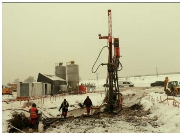
Fot. 1 | Wykonywanie mikropali, w tle zaplecze iniekcyjne
