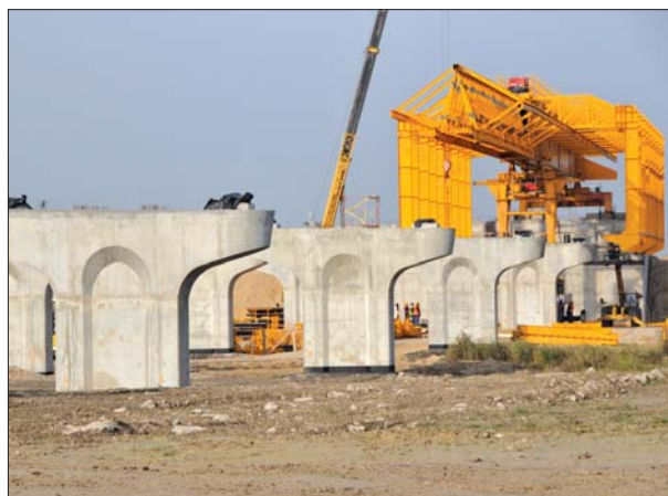
Fot. 4 | Filary gotowe do betonowania przęsł
