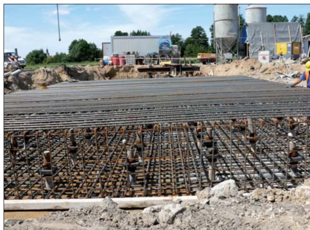
Fot. 2 | Fundament mikropalowy przed betonowaniem
