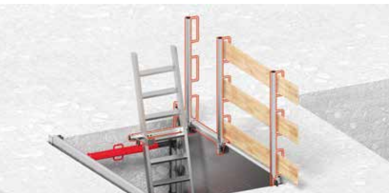
Ryc. 7. Bezpieczne zejście do wykopu
