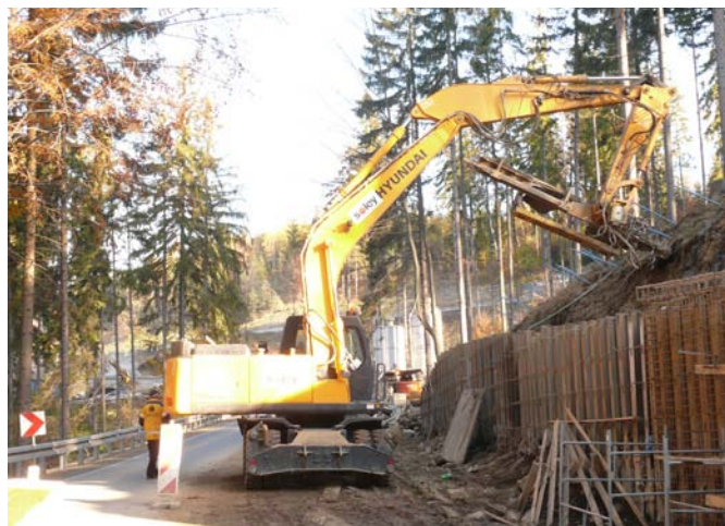
Fot. 26. Osuwisko nr 2. Gwoździowanie górnej części niszy
