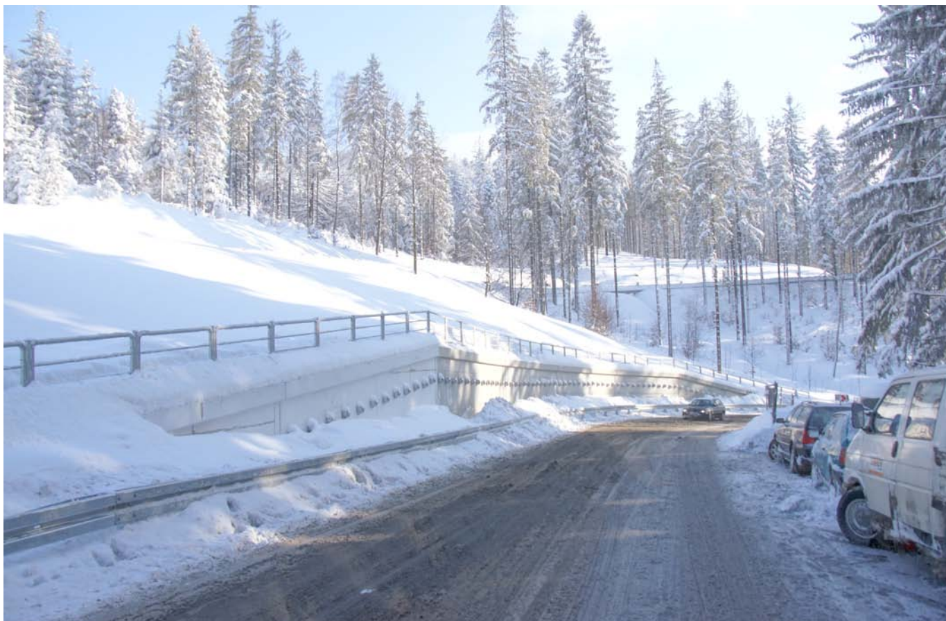
Zimowy widok na zabezpieczone osuwisko nr 1
