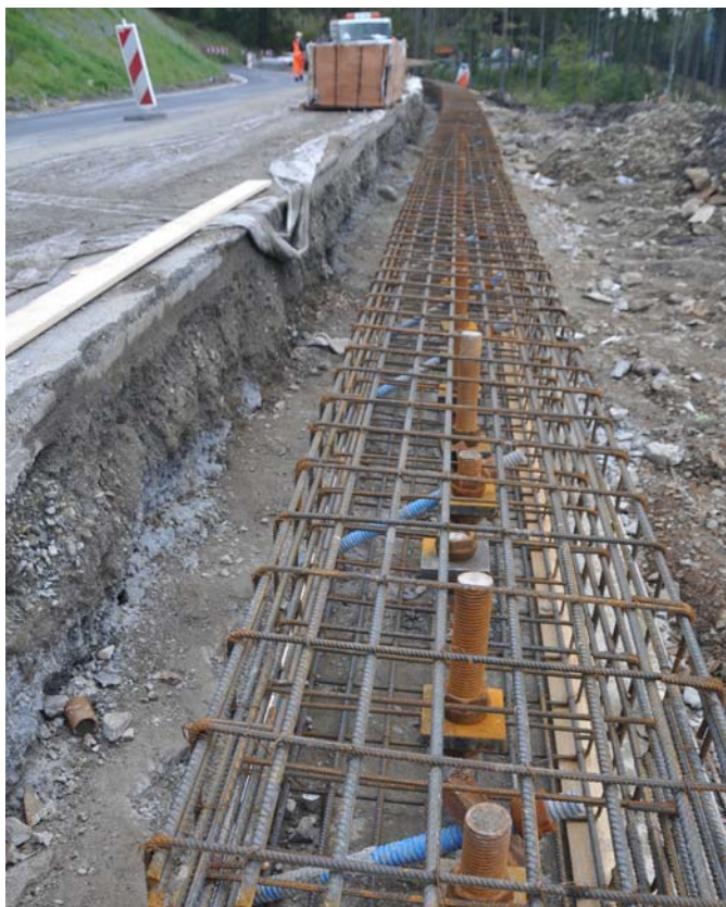
Osuwisko nr 1. Górna bariera mikropalowa
