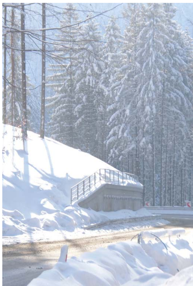
Zimowy widok na zabezpieczone osuwisko nr 2
