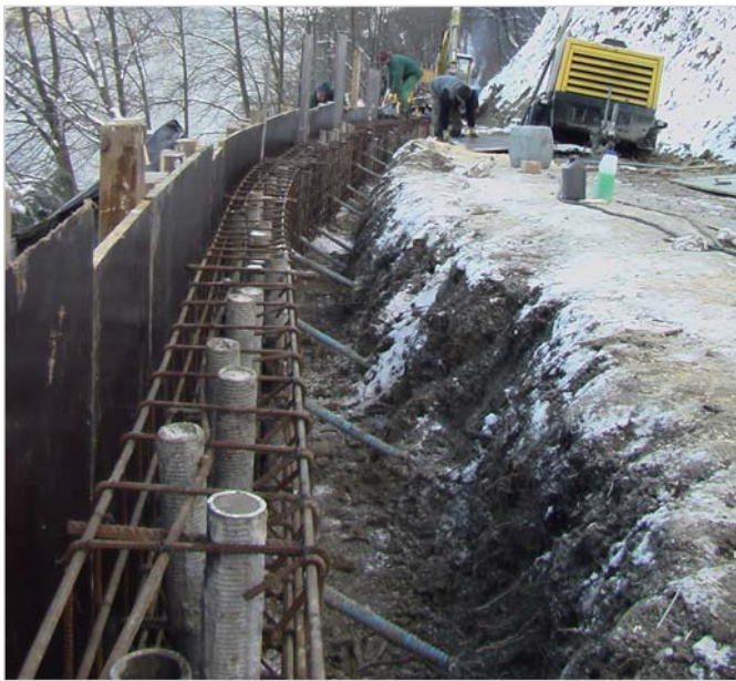
Ryc. 15. Formowanie ściany tesyńskiej.
