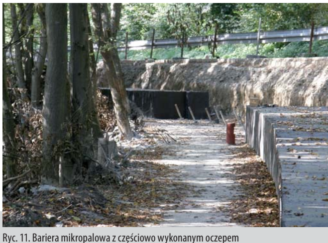
Ryc. 11. Bariera mikropalowa z częściowo wykonanym oczepem
