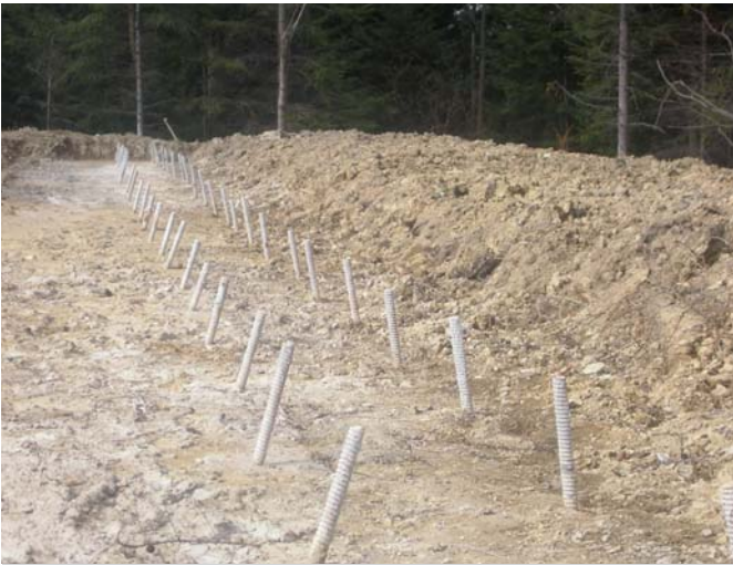
Ryc. 10. Mikropale tworzące barierę
