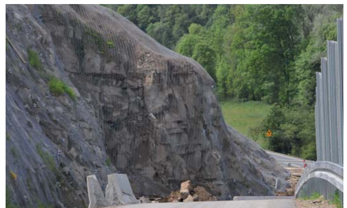
Ryc. 5. Widok zabezpieczonych skarp i urwiska skalnego. Lubień
