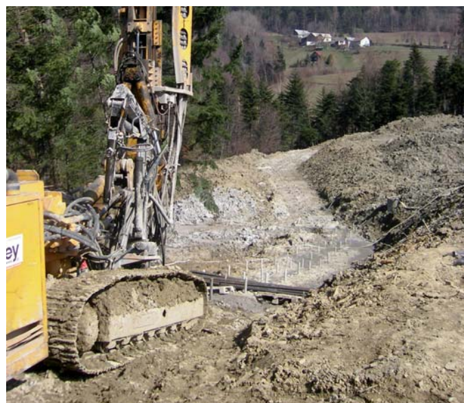
Ryc. 9. Wykonywanie bariery mikropalowej
