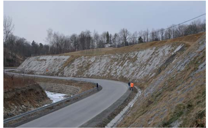
Ryc. 3. Widok zagwoździowanych skarp osuwiskowych z oblicowaniem elastycznym. Szymbark
