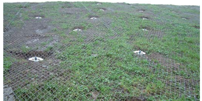
Ryc. 4. Widok skarpy gwoździowanej z oblicowaniem elastycznym po zazielenieniu. Grodziec Śląski
