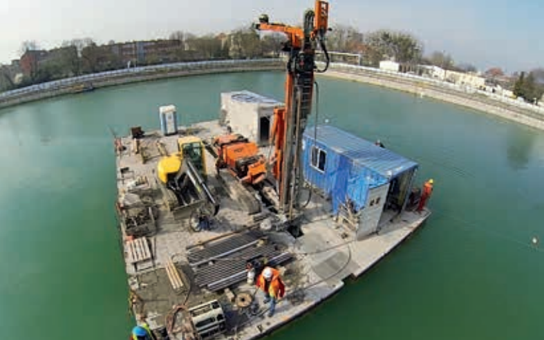
Wykonywanie mikropali z platform pływających
