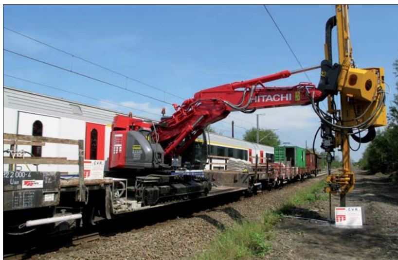
Fot. 1 | Wykonywanie fundamentów słupów trakcyjnych przy czynnej linii kolejowej
