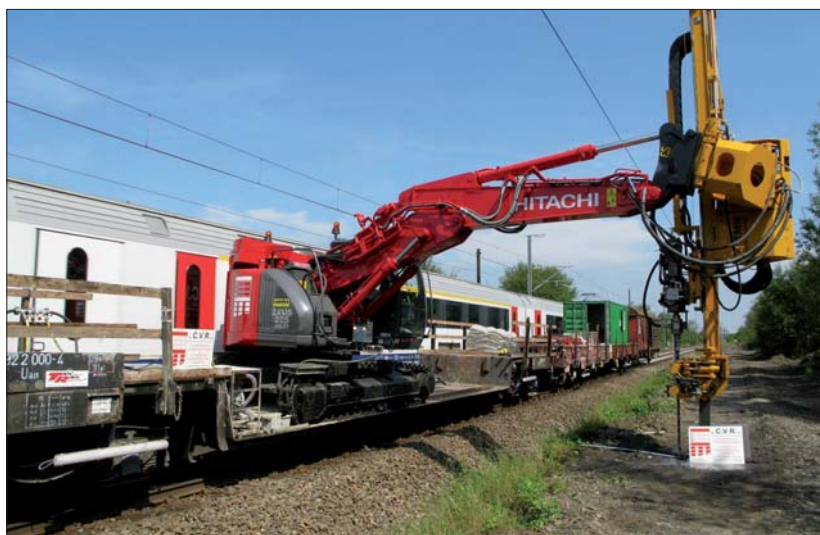
Fot. 1 | Wykonywanie fundamentów słupów trakcyjnych przy czynnej linii kolejowej
