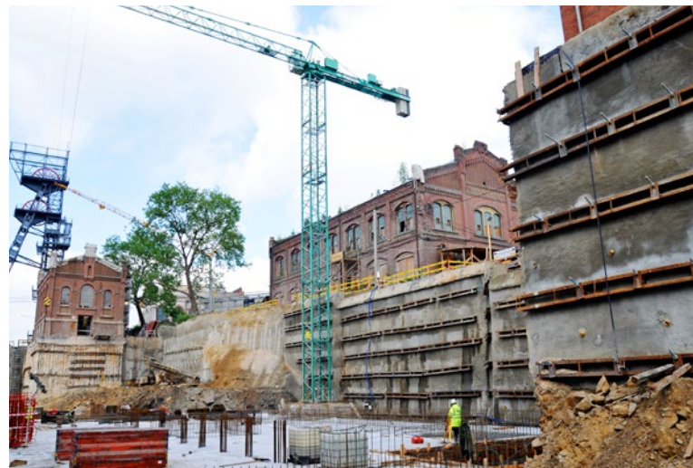
Ryc. 3. Głęboki wykop przylegający do zabytkowych obiektów zabezpieczony w różnych technologiach – w budynku w głębi wykonywana jest nowa kondygnacja podziemna z tunelem pod ścianą szczytową
